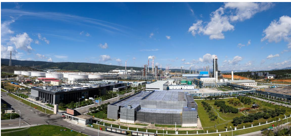
图 1 云南石化项目全景
